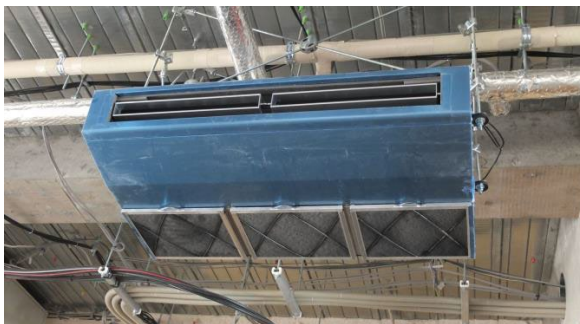
▲ 厨房用の冷暖房機 2台設置
