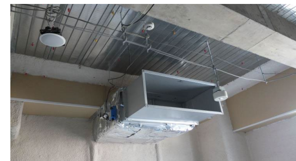
▲ 強力な排気用ダクト設備
