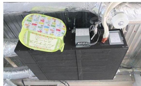
◀ 冷暖房の熱を利用する熱交換機
