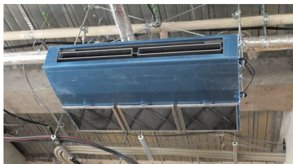
▲ 厨房用の冷暖房機 2 台設置
