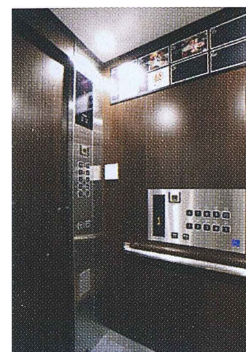
エレベーター内部
