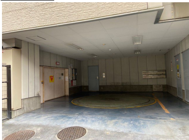
機械式駐車場
