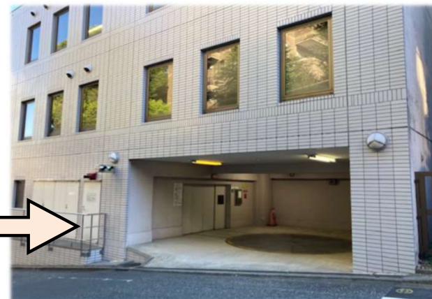
【機械式駐車場】
