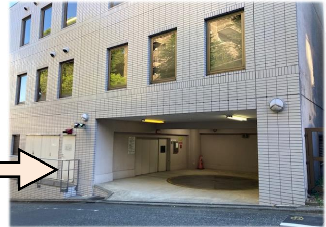
【機械式駐車場】
