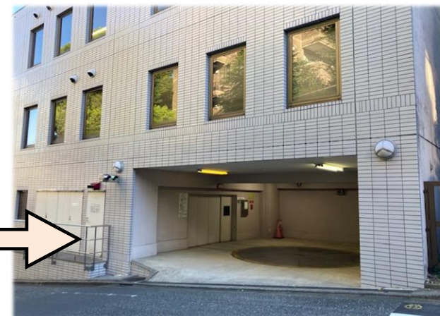
【機械式駐車場】
