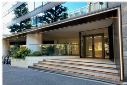
【ビルエントランス】
