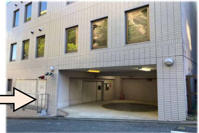
【機械式駐車場】
