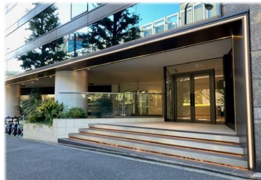
【ビルエントランス】
