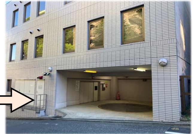
【機械式駐車場】
